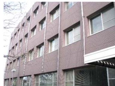
外壁塗装を行った10号館
